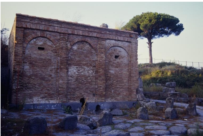
Wasserverteilerhaus von Pompeji (Italien)
